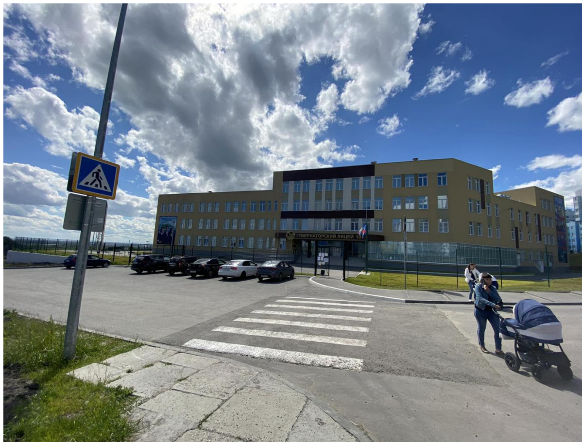
Пути подъезда к зданию МБОУ г. Ульяновска «Губернаторский лицей № 101»
